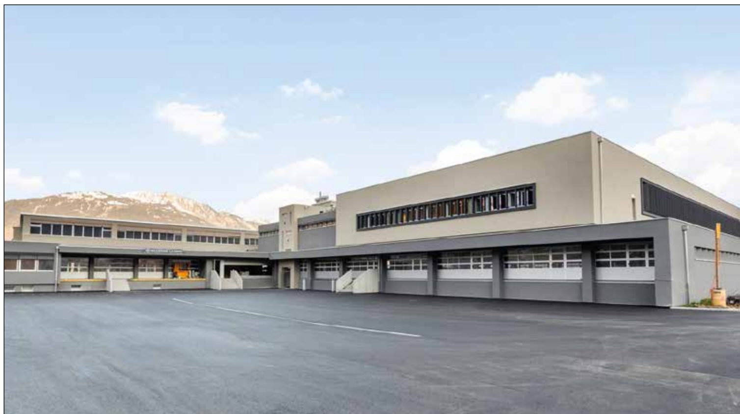
Plus de 10 millions de francs d'investissement ont été nécessaires pour assainir et remettre aux normes le site de Bex/VD.
